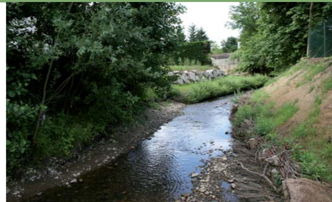
Aménagement des berges de l'Onzon en techniques végétales
