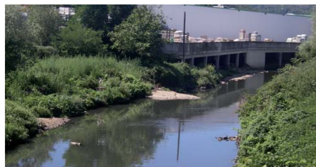
Ancien site du magasin Leroy Merlin à Ratarieux
